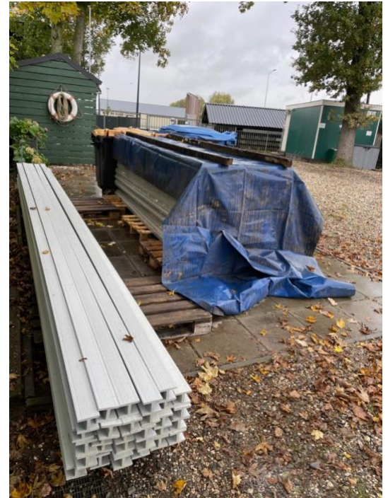
De liggers en onder het plastic de GVK roosters
