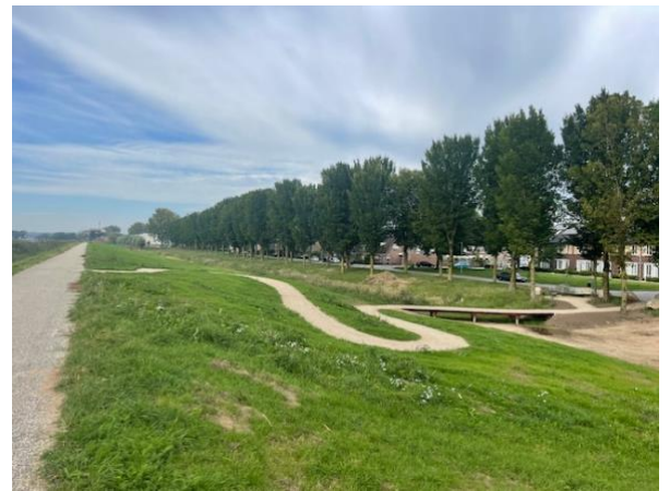
Hellingbaan op de Ooi tussen onze haven en het viaduct over de Rivierweg.
