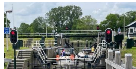
Waaiersluis met schutting van 2 boten per keer
