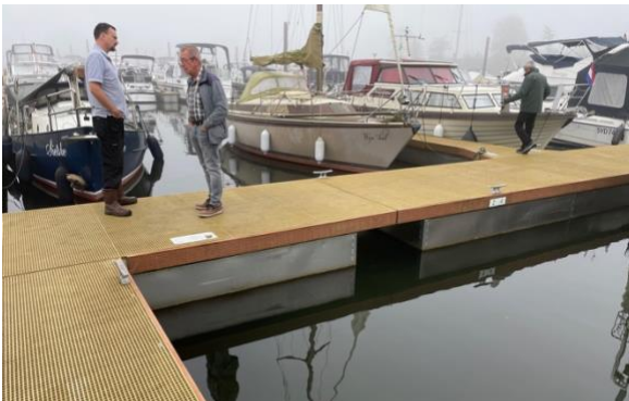
Impressie van de nieuwe steiger. Bij ons komt er een grijs GVK rooster op. Foto bij een referentiebezoek aan de Batavier in Niftrik
