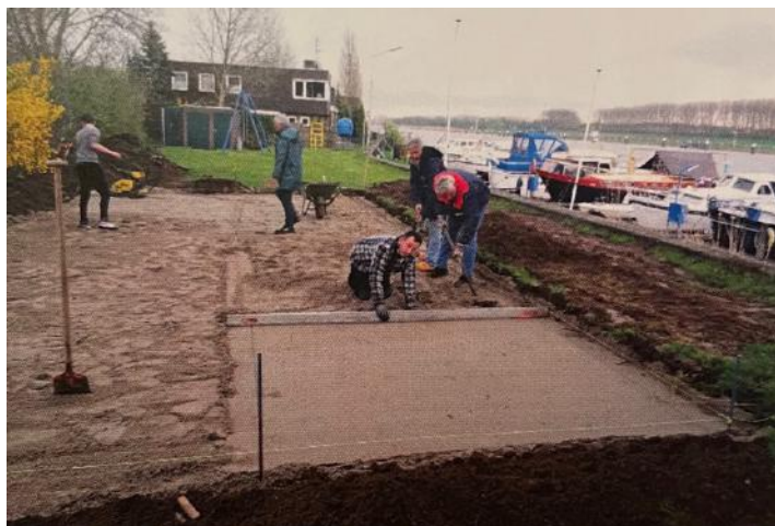
Leggen van Stelconplaten 2016
