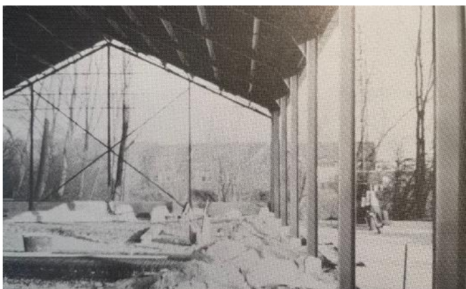
Winterberging in 1977 in aanbouw
