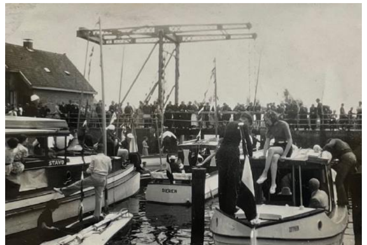
GWT 1938 in de oude sluis met veel belangstelling op de brug
