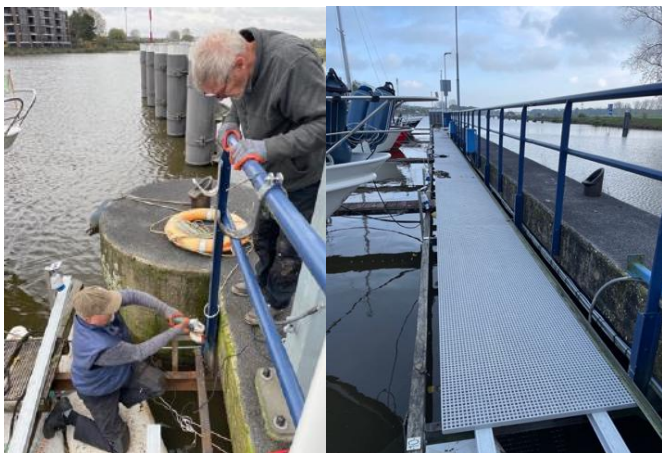
Werk aan vernieuwing hoofdsteiger op Zuid (2023). Op de foto Alwin Wolbers (l) en Ed Morren (r). Het resultaat: een strakke steiger met GVK roosters.
