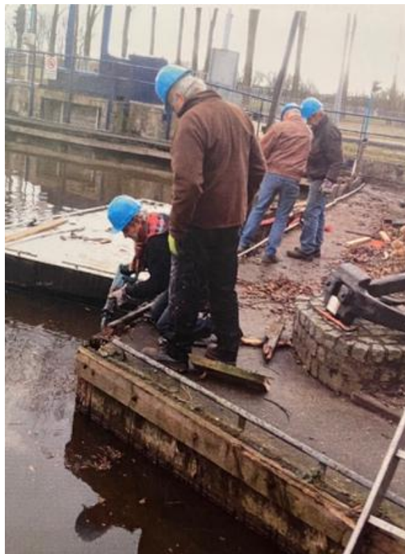
Vervangen van de damwand in 2016
