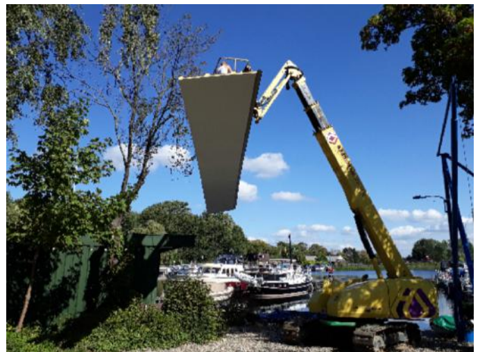
2018 Het nieuwe dak op het botenhuis wordt geplaatst
