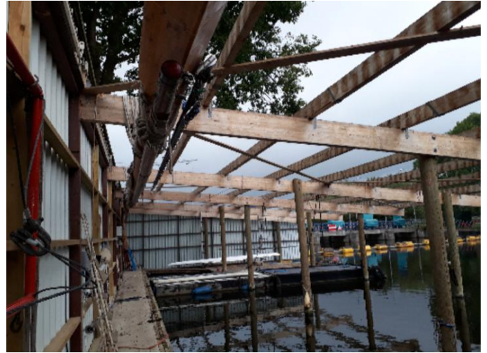
2018 het oude dak wordt verwijderd
