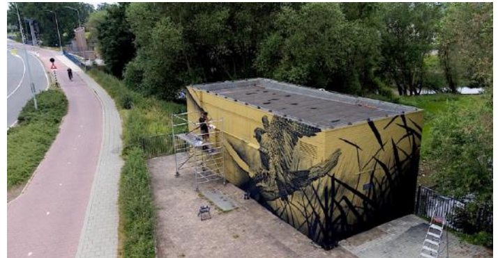
Gemaal 2021 op de plek van het benedenhoofd van de oude sluis, de verbinding tussen de Oude IJssel en de Gelderse IJssel
