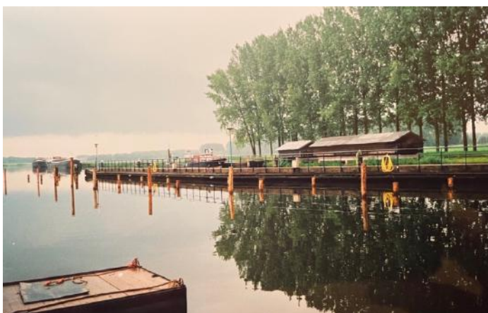
Uitbaggeren en nieuwe palen en vingersteigers in 2004
