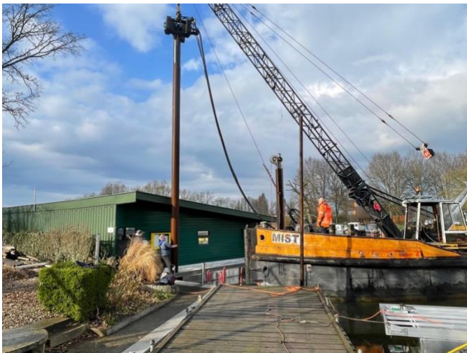
12 meter buispaal, en dan ook nog waterpas krijgen
