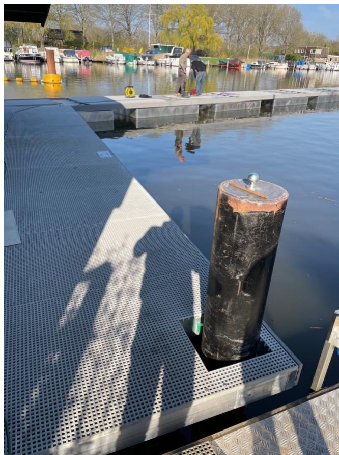
Alle palen voorzien van afdichting met trekhaak
