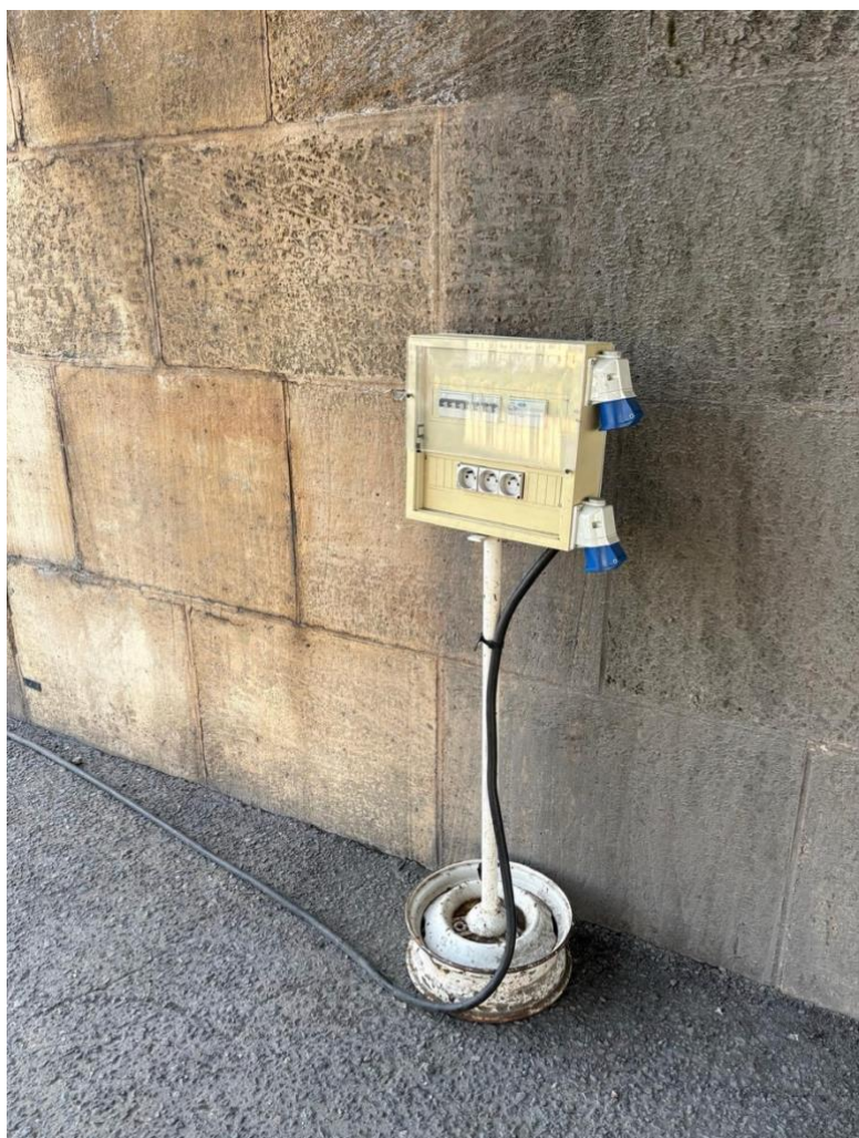
Zo kun je de elektra ook aanleggen. Foto van Richard en Jolanda uit Fr.
