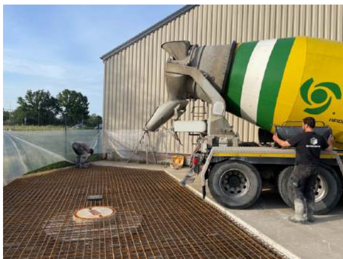
Storten van het beton, de kanten netjes met plastic afgedekt
